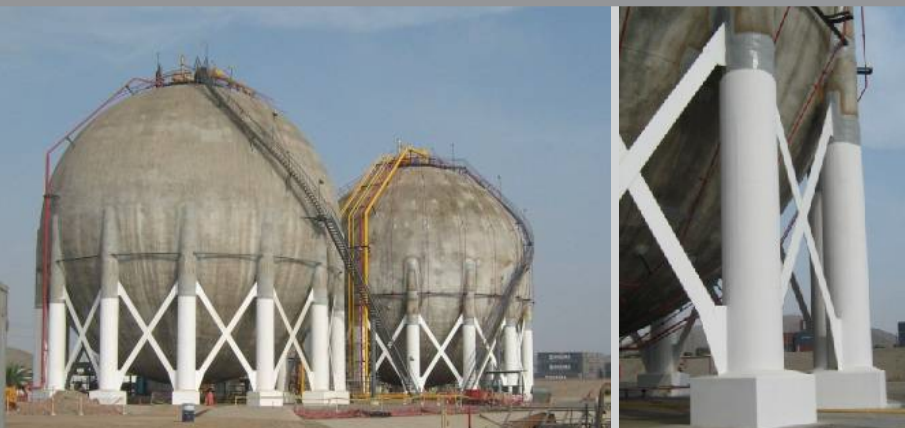
Planta de almacenamiento Repsol Ventanilla.
