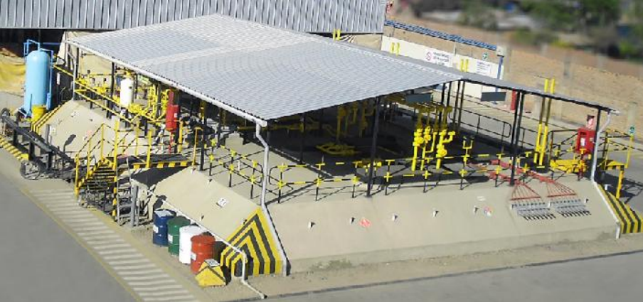
Planta de envasado Repsol Huancayo.
