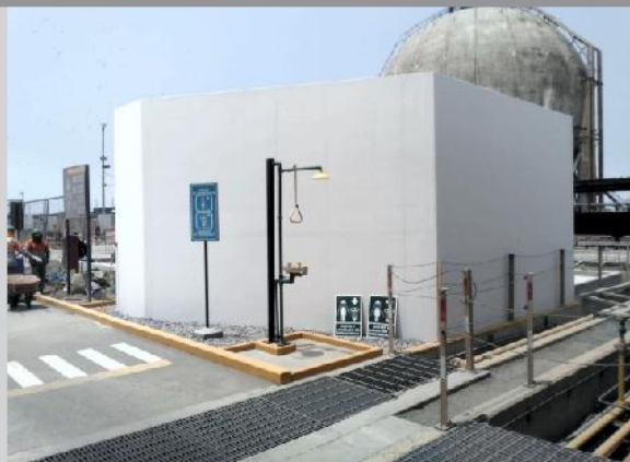
Planta de almacenamiento Solgas Ventanilla.
