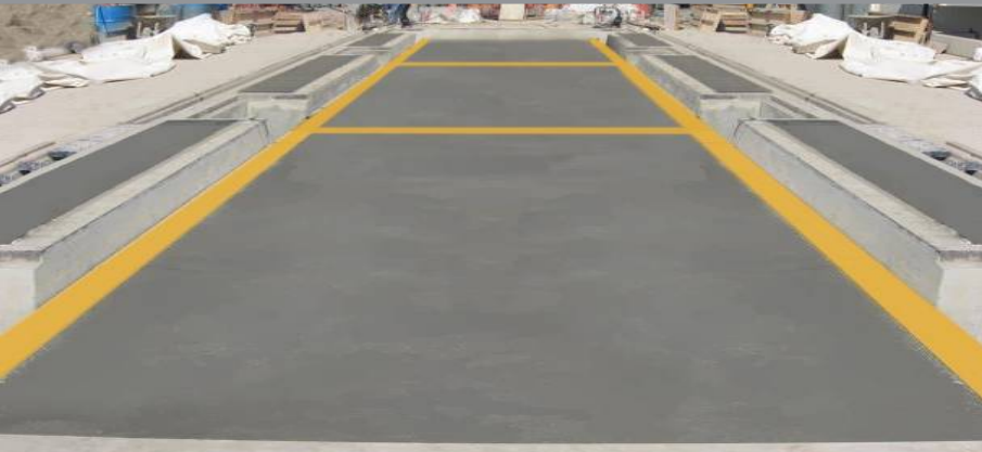
Planta de envasado Repsol Huancayo
