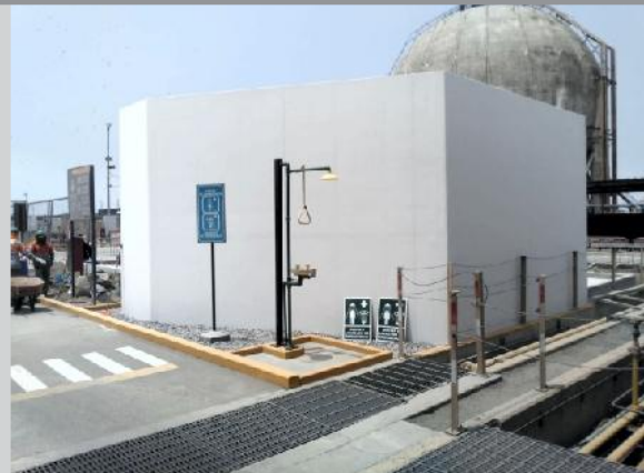
Planta de almacenamiento Solgas Ventanilla.
