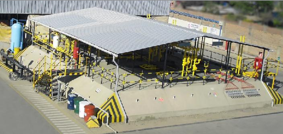
Planta de envasado Repsol Huancayo.
